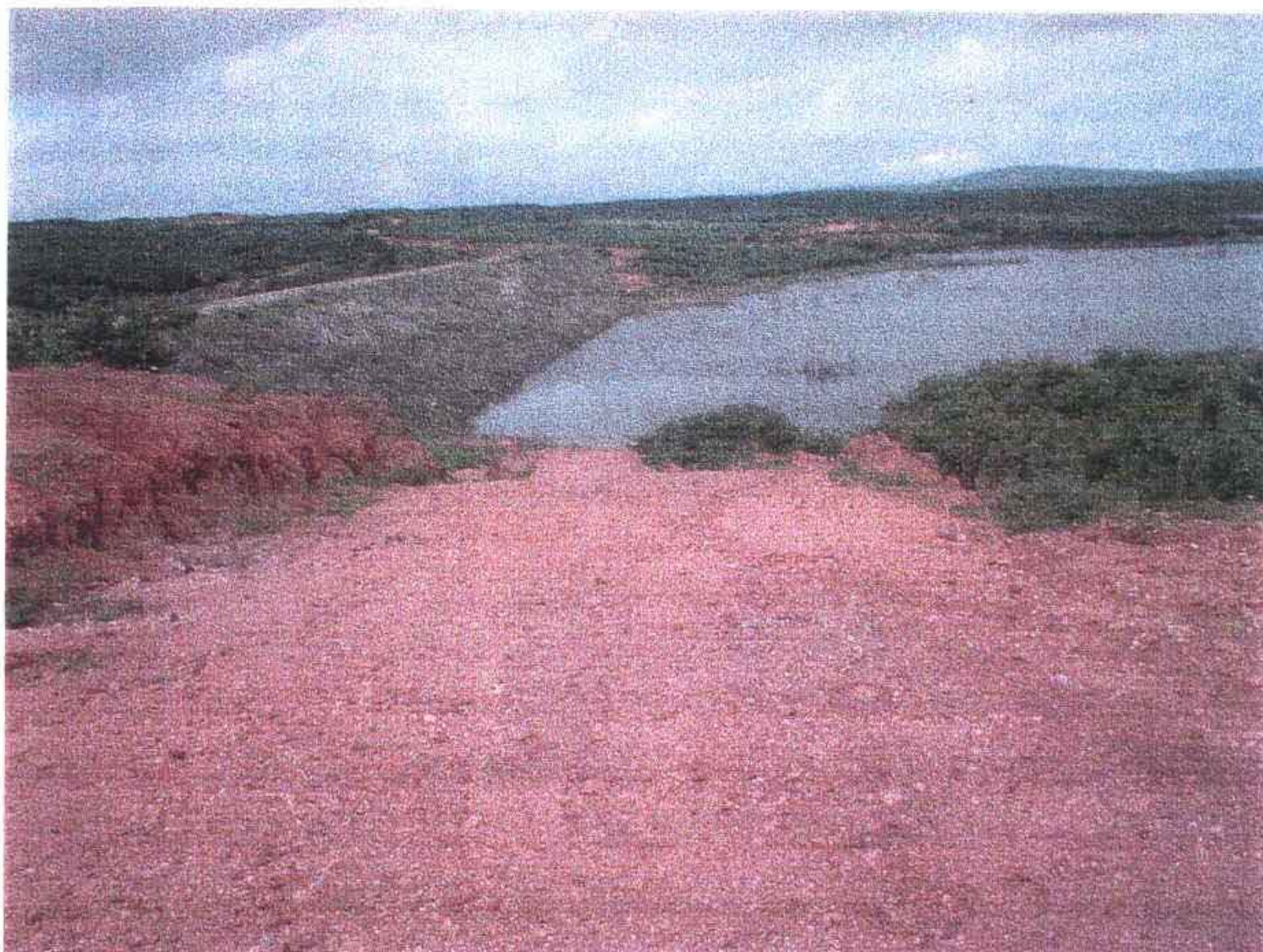
Vista da ombreira esquerda do Aç. Publico JENIPAPEIRO II com a parede
